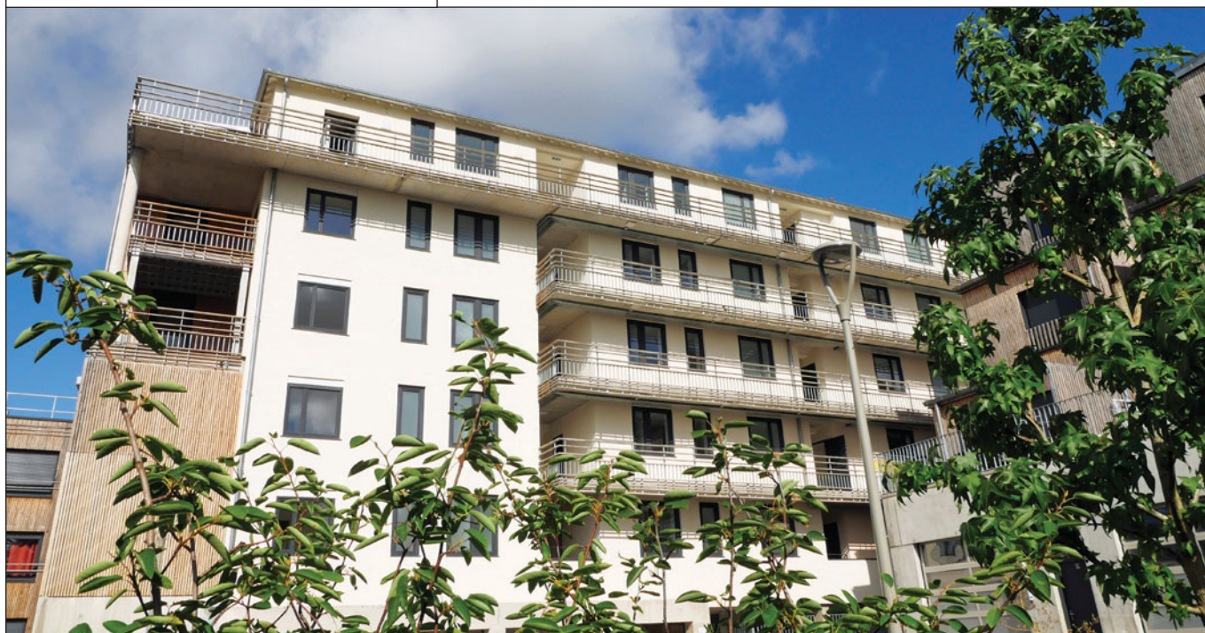
Résidence Les Sauvères - 38 logements - Thorigny-sur-Marne
